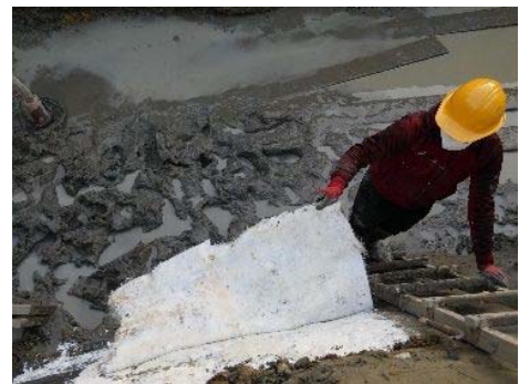
図2 剥ぎ取り作業の様子
