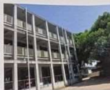
(図1) 開放的な校舎(教室棟)
