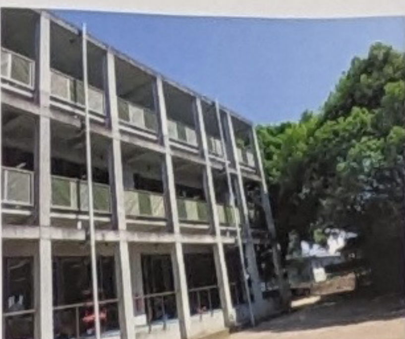
(図1) 開放的な校舎(教室棟)
